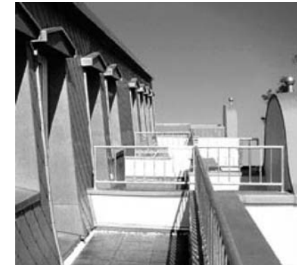
Фото 14.2: Использование RHEINZINK® - строительных профилей для покрытия парапетов
