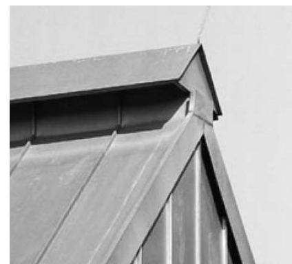
Фото 7.1: Узел соединения конька на фронтоне, высокий вариант
