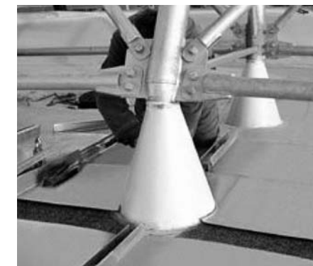
Фото 4: Область кровли с большим количеством проёмов
