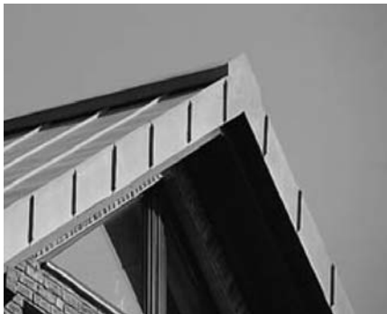
Фото 7.2: Узел соединения конька с ребром, низкий вариант
