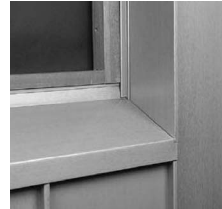
Фото 11: Оконный проём с боковым примыканием к парапету
