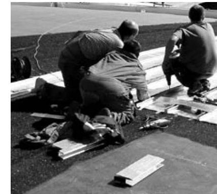
Фото. 5.3: Структурная мембрана без пленки, Enka®-Vent
